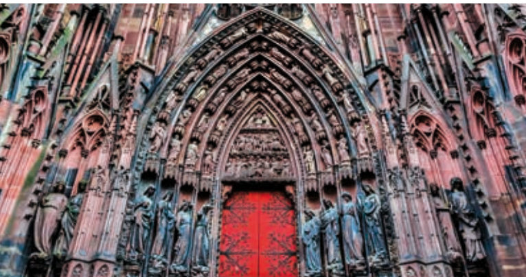
Westfassade der Kathedrale
