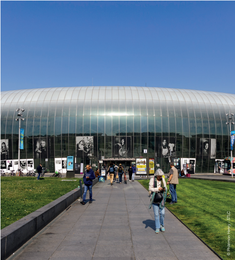
Parvis de la gare de Strasbourg
